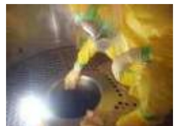
開放点検時系統内除染作業(3)
