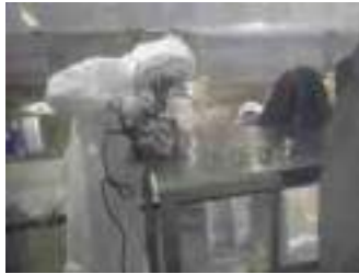
グローブボックス解体撤去作業
