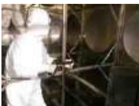
排水設備内の清掃
